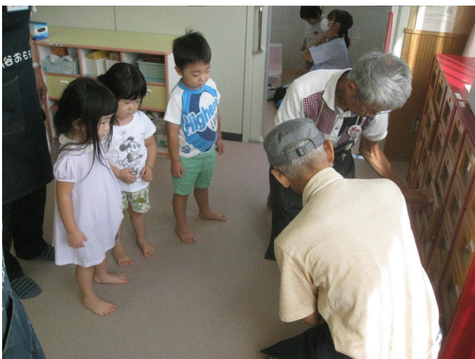
園児のしている前で整理棚の引き出しを修理
